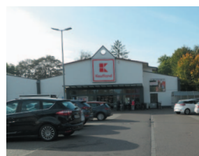
Gewerbeobjekt in Langenau
