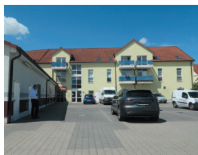
Wohn- und Geschäftshaus in Oschersleben
